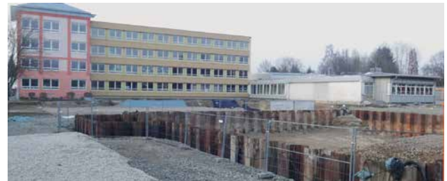
Landau: Jetzt noch Baugrube später das neue Förderzentrum.
